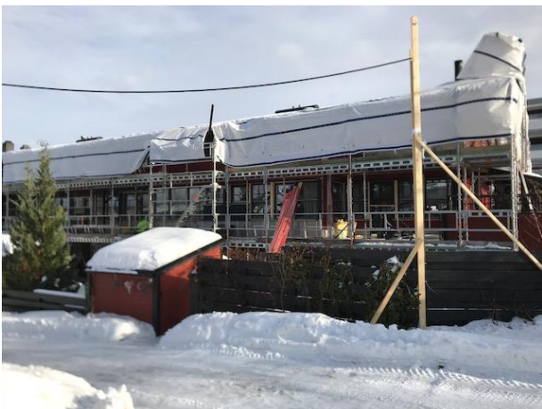
Snørik vinter på byggeplassen!
