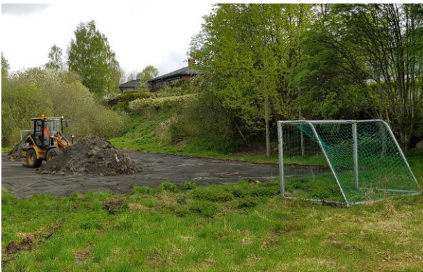
21. mai 2021. Vedlikehold av fotballbanen i bydelsparken. Det gamle grusdekket skrapes av før bortkjøring.
